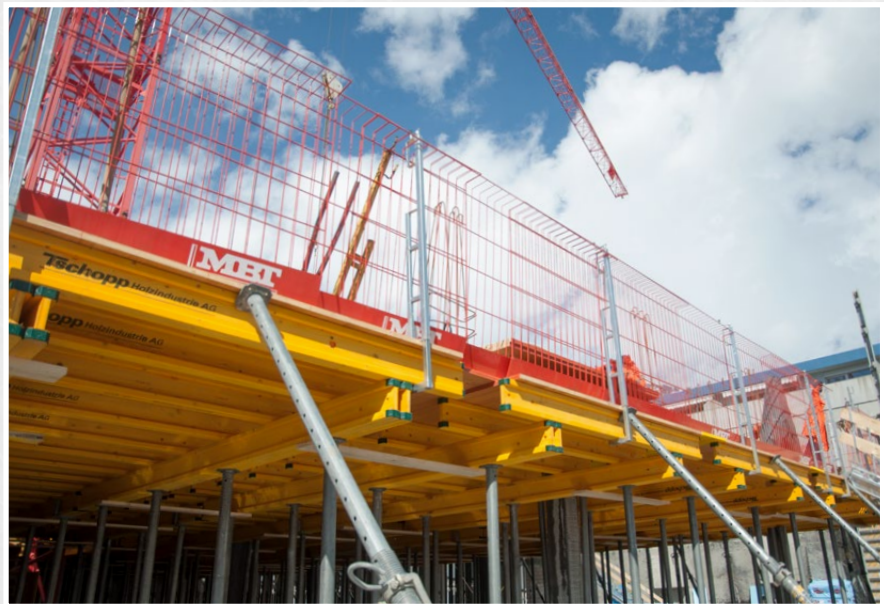
Safe-Gard monté sur une table de coffrage avec l'étaçon à manivelle Safe-Gard
