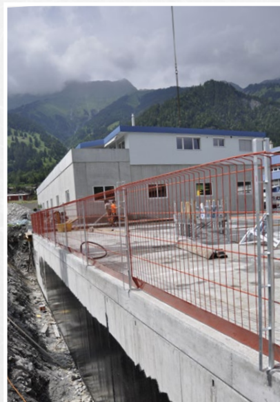
Le montant de barrière Safe-Gard s'insère simplement dans la capsule de réservation
