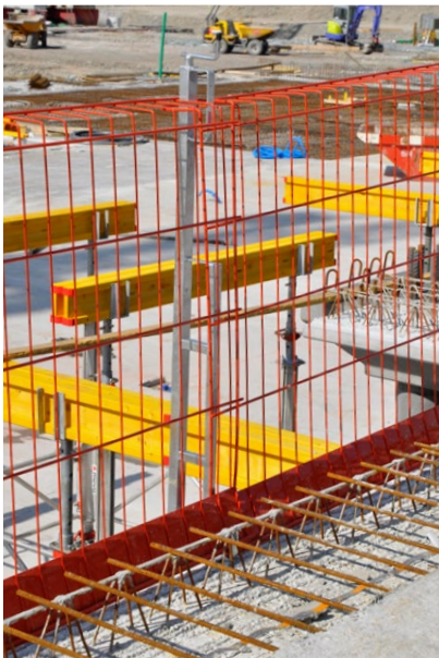
Safe-Gard avec un étaçon à manivelle Safe-Gard
