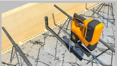
Introduire les chevilles à clouer Ø6x35 dans les trous des prédalles à travers les trous des équerres Randfix et les enfoncer au marteau.
