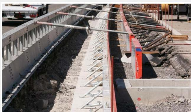
Maxi-Form vissé sur du béton dans la construction de routes
