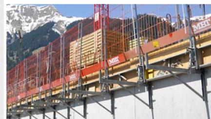
Coffrage de rive de dalle avec Maxi-Form et console BKA Pro 100 cm et avec protection latérale constituée de Safe-Gard
