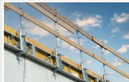
Coffrage de rive de dalle avec Maxi-Form et console BKA Pro 30 cm et avec protection latérale constituée de montants de barrière et planches en bois
