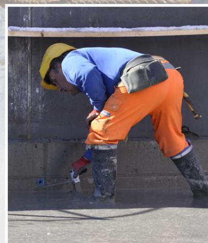
Pose des capsules de réservation dans le béton frais
