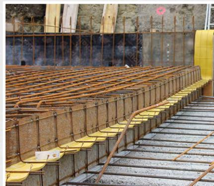
AEF avec bande couvre-joint insérée
