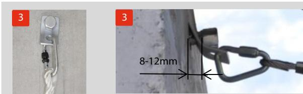
3. Sur le point d'ancrage il faut installer un EPI contre les chutes correspondant au moyen d'une liaison contrôlée. Le point d'ancrage KiBo Steinadler doit pouvoir tourner autour de la vis de liaison après le montage.
