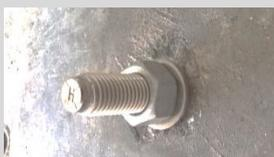
Placer l'ancrage à béton et la laisser dépasser de 45 mm. Serrer l'écrou à 110 Nm.
