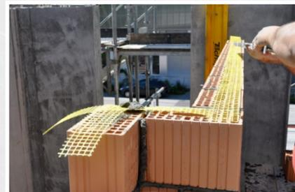
Wall-Grip est simplement déroulé au milieu du joint d'assise et recouvert par la maçonnerie
