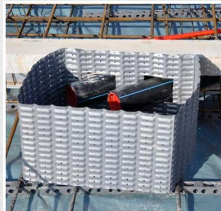
Des traversées par des installations de construction sont aussi possibles
