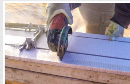
Das Bordfix Element kann mit der Stichsäge oder dem Winkelschleifer mühelos auf die gewünschte Länge zugeschnitten werden
