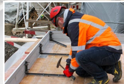
Zum Fixieren des 2.8 m langen Bordfix Deckenwinkels werden die Winkel ausgeklappt und mit Aluminium-Nägeln befestigt
