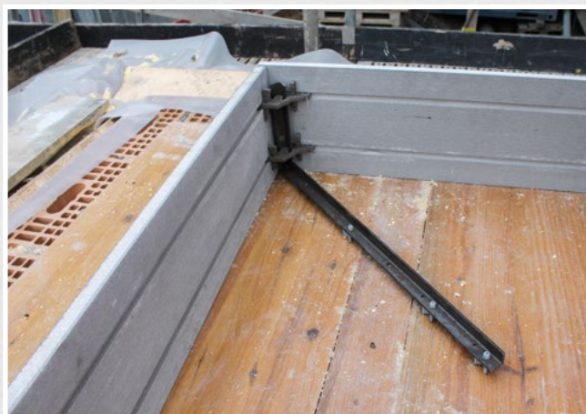
Die Bordfix Deckenwinkel können von eingeklappt bis auf 90° stufenlos gerichtet werden
