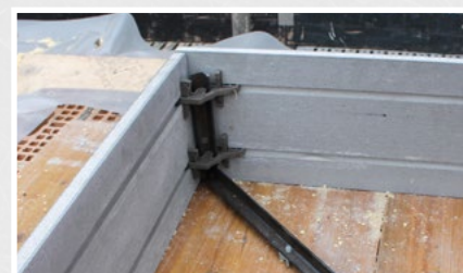
Auch bei Ecken lassen sich die Elemente ganz einfach kraftschlüssig verbinden und der Winkel ausrichten
