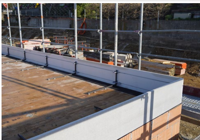
In Ecken oder in Längsrichtung lassen sich die Bordfix Elemente ganz einfach kraftschlüssig mit den Läufern verbinden
