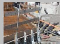
S'assurer que la goupille du montant s'encliquète dans le trou de blocage du chariot BKA Pro de façon à ce que le montant ne puisse pas être retiré involontairement.
