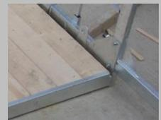
Visser les tirants avec les vis et écrous à levier M20 x 40 mm livrés.
