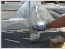
Insérer et visser le longeron transversal frontal et les faces avec les vis et écrous à levier M16 x90 mm.
