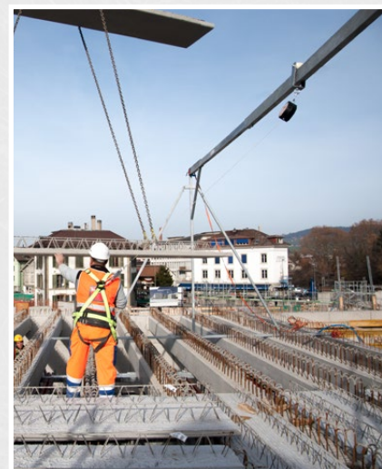
Des travaux sécurisés grâce à Life-Gard
