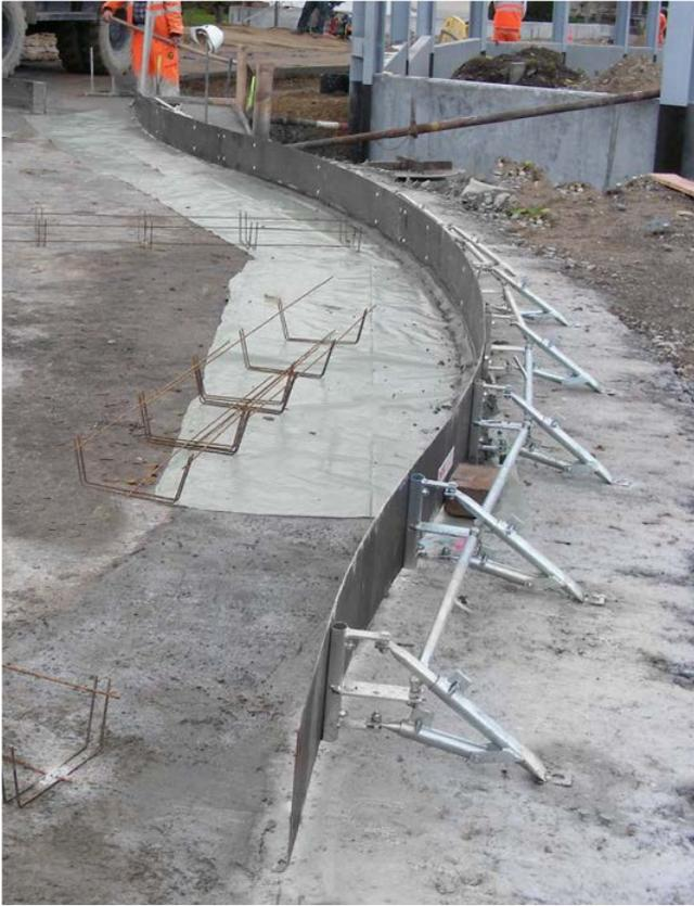
Les pieds d'appui permettent un ajustement exact du coffrage de rond-point
