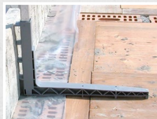
Équerre plastique fixée avec des clous en aluminium 3,1 x 55 mm
