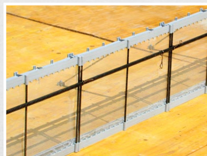
Net-Form fixé avec des clous en aluminium
