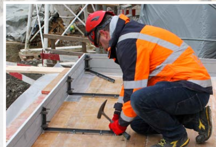
Pour fixer l'élément Bordfix de 2,8 m de long, les équerres sont dépliées et fixées avec des clous en aluminium.
