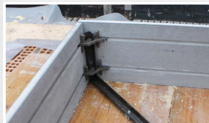
Dans les angles aussi, les éléments peuvent être assemblés solidement et les équerres alignées.
