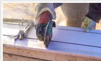
L'élément Bordfix peut être facilement coupé à la longueur désirée à la scie sauteuse ou à la meuleuse d'angle
