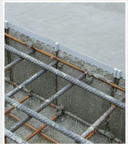
Sans crochet de fixation ou avec pression du béton élevée, une ferrure transversale montée devant Net-Form, sur les armatures est une bonne solution
