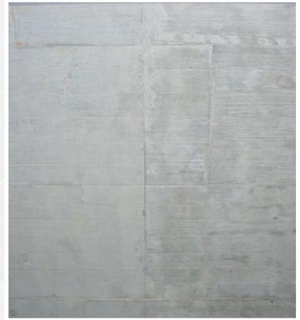
*Net-Form convient aussi pour le béton apparent.*
