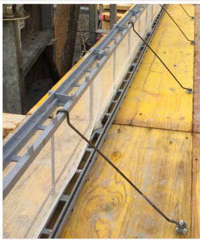
Les crochets de fixation en option permettent d'aligner et de monter aisément Net-Form
