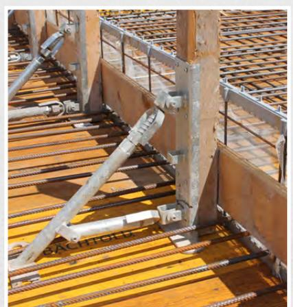
À des vitesses de coulage élevées, nous recommandons l'utilisation d'un renfort à partir d'une épaisseur de dalle de 36 cm, p. ex. notre BPA
