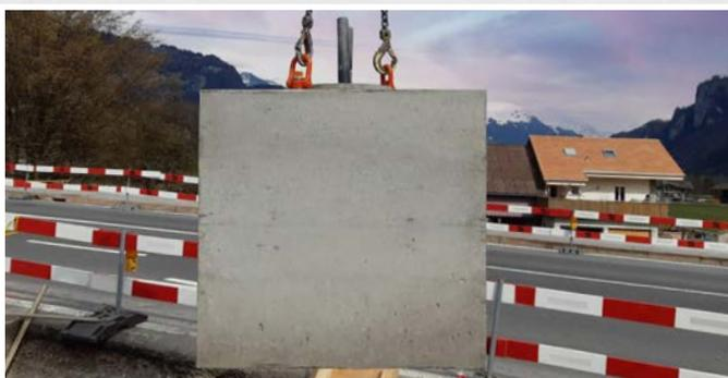
L'anneau de levage 360° permet le transport sûr des éléments en béton
