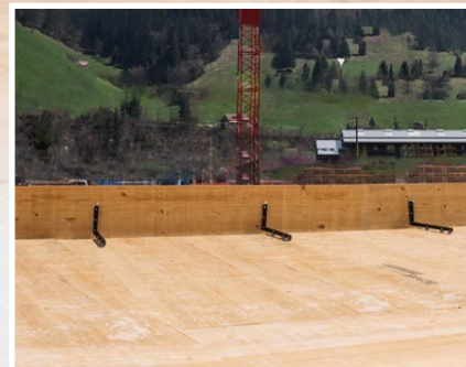
Randfix pour le coffrage de rives de dalle
