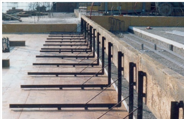
Randfix convient également pour des coffrages progressifs
