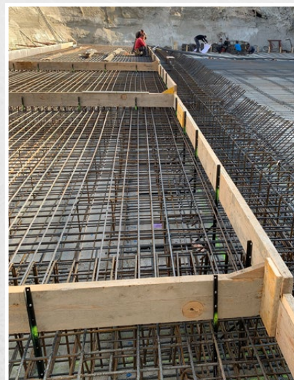
Randfix convient également pour le coffrage des décrochements
