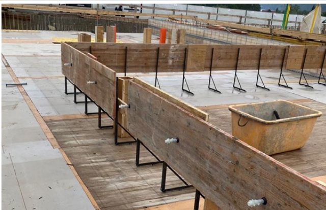
Randfix convient également pour le coffrage des décrochements
