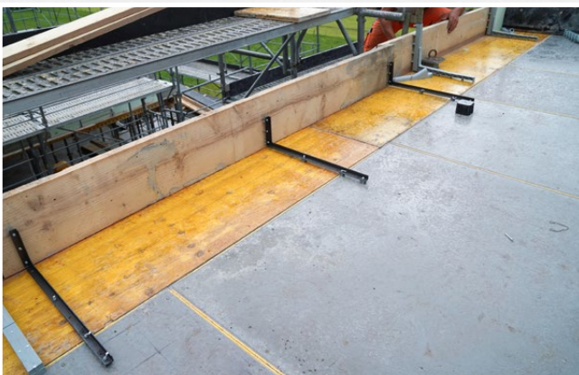
Avec le système Randfix ça vous offres un coffrage rapide
