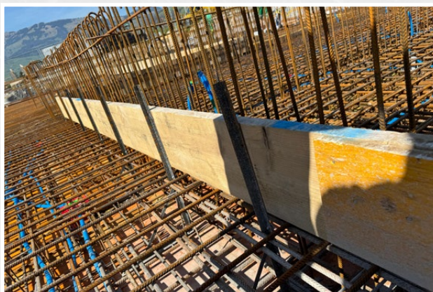
Randfix convient également pour le coffrage des décrochements
