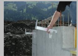
Poser une planche d'échafaudage sur les crochets d'appui BKA Pro.
