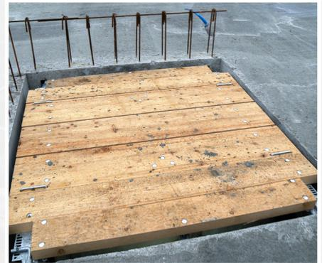
La cage d'ascenseur solidement fermée permet la pose de coffrages de dalle et de mur
