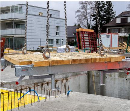
La plateforme Lift repose sur 4 resp. 6 pieds pour le stockage et peut être empilée pour gagner de la place. Elle peut être mise en place de manière optimale à l'aide de la grue de chantier grâce aux 4 points de levage
