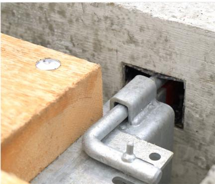
En plus de l'accrochage automatique, la goupille de sécurité empêche le déplacement de la plateforme Lift
