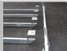
Introduire les faces dans les longerons transversaux. Les cames de guidage soudées sur les faces marquent la position des longerons transversaux.
