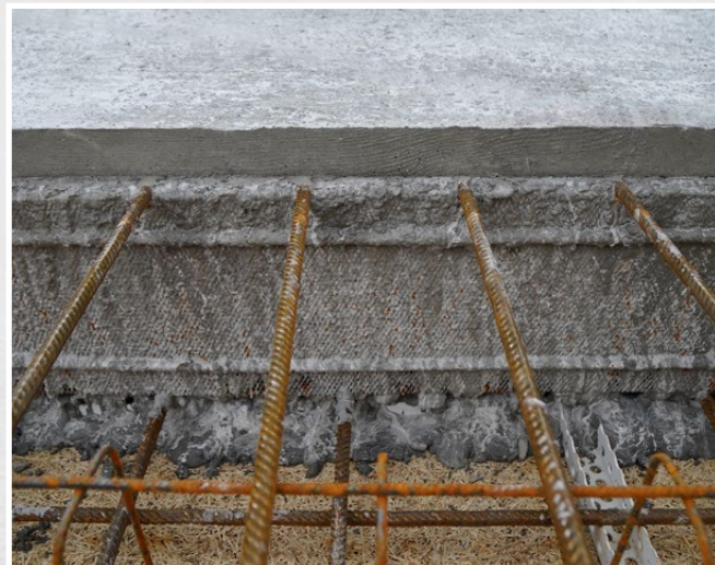
AES après le coulage et le retrait du bois équarri
