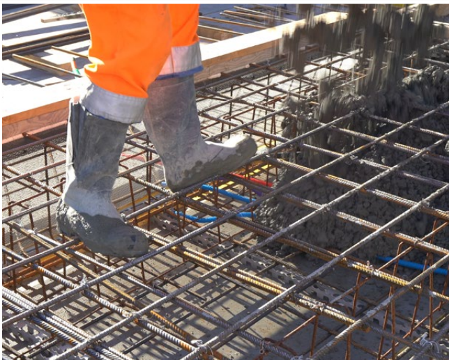
AES lors du coulage du béton
