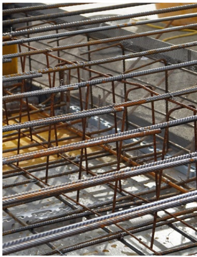
La troisième et quatrième armatures peuvent être posées proprement sur AES
