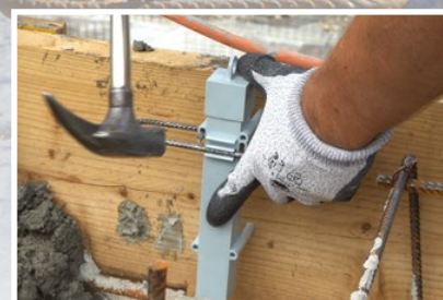
La capsule de réservation à clouer peut être fixée de manière simple, de préférence avec des clous en aluminium
