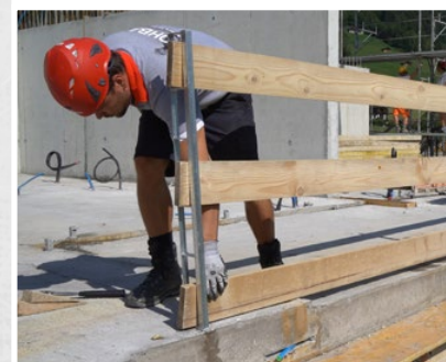
Le montant de barrière MBT permet ensuite de mettre en place avec une grande facilité une protection latérale sûre selon EN 13374
