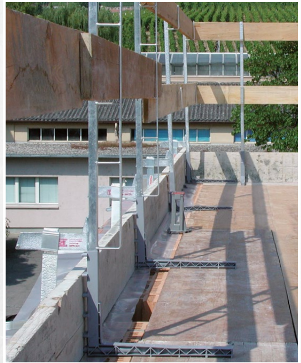
Coffrage de bord de dalle et pince Kombifix avec barrière de sécurité
