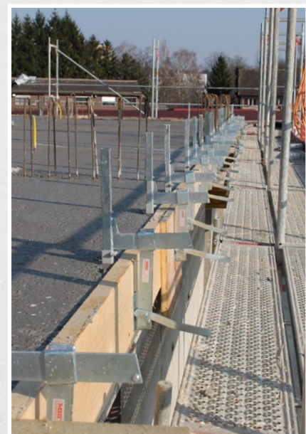
Équerre Kombifix utilisée avec la pince Kombifix après le bétonnage
