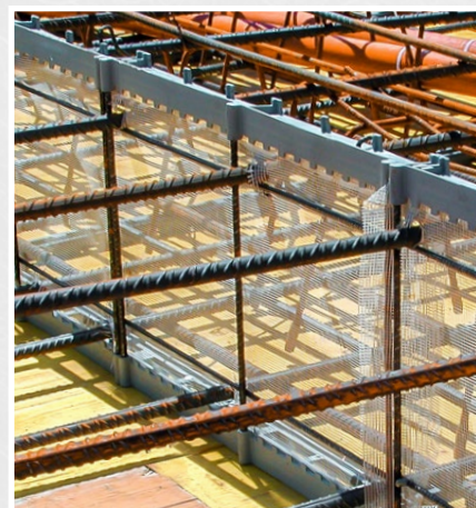
L'armature peut être facilement enfoncée à travers le treillis et posée
