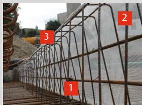
Pose de l'armature supérieure et fixation d'une planche de bout.
