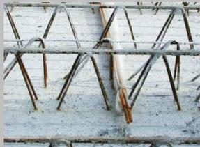
Lorsque la couche d'armature est plus haute, il est possible de tirer le fer et d'inciser le treillis. Le fer tiré peut être introduit dans le treillis au-dessus de la couche d'armature supérieure et fixé.
