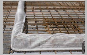
Insertion de divers équipements. Inciser une croix dans le treillis, faire passer les équipements et coller les languettes du treillis sur l'installation à l'aide d'un ruban adhésif.
