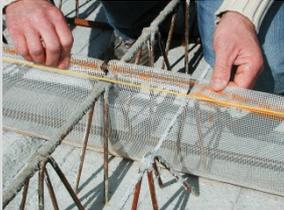
Fixation d'une planche de bout sur la couche d'armature supérieure.
