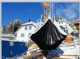
Pour vider la bâche de la neige ou des matériaux en vrac, décrocher deux anneaux de suspension de la grue et retirer la bâche avec la grue.
