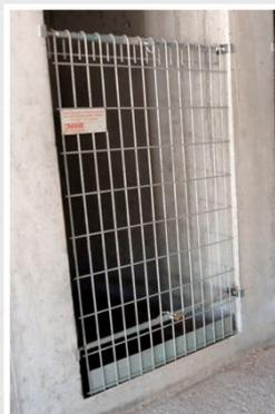
La grille peut être protégée contre un accès interdit ou un démontage prématuré à l'aide d'un cadenas
