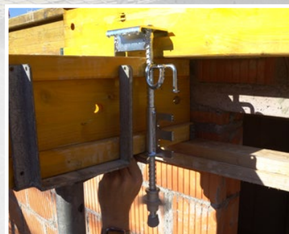
Serrer le support pivotant avec la poutrelle primaire et la poutrelle secondaire
