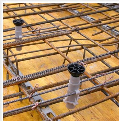
UNO-Ankerfix fixé sur un acier d'armature
