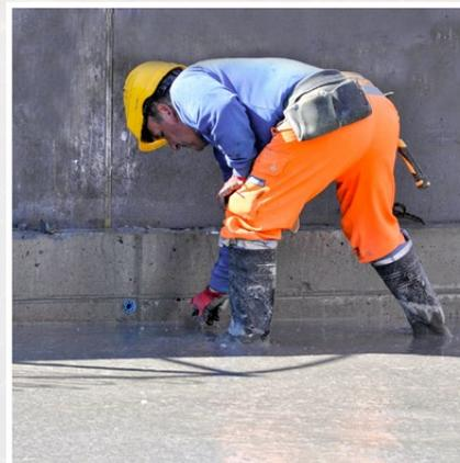
Pose de l'UNO-Ankerfix dans du béton frais
