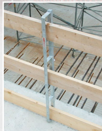
Protection latérale avec montant de barrière et planches en bois
