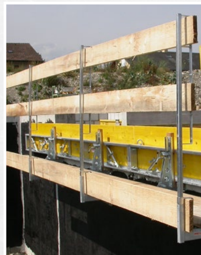
Montant de barrière en combinaison avec la console BKA Pro
