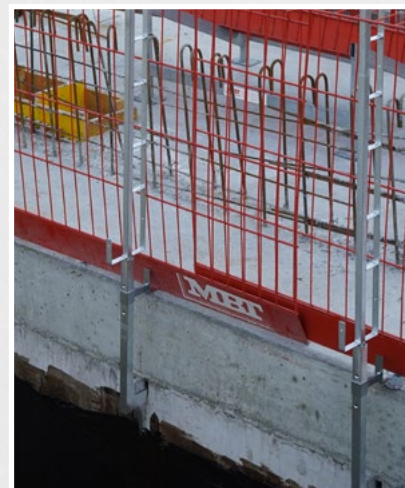
Adaptateur BKA Pro avec support de plinthe et planches en bois
