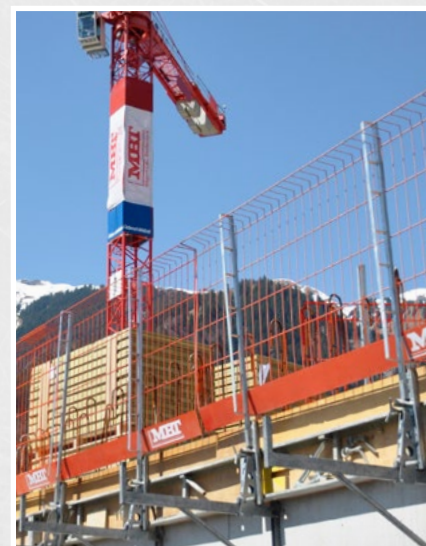
Montant de barrière en combinaison avec Safe-Gard, BKA Pro et Maxi-Form
