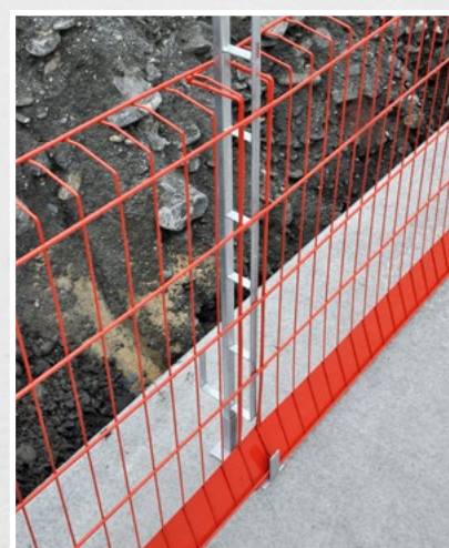
Montant de barrière avec Safe-Gard et plaque de sol
