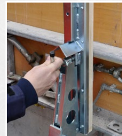
Ajuster la goupille avec le goujon d'ajustage
