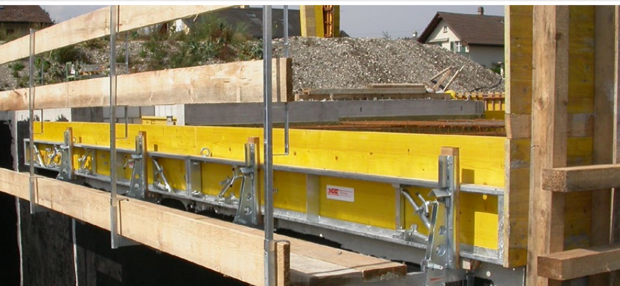
Consoles BKA Pro avec Maxi-Form et un échafaudage avec protection latérale
