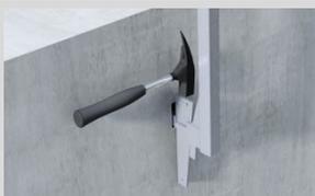
S'assurer que l'adaptateur BKA Pro est correctement placé dans la réservation BKA une fois monté et bloqué.
