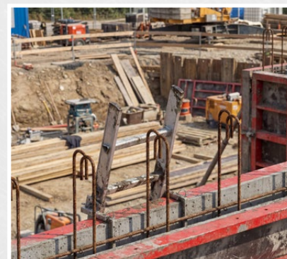
Accrochage du support d'échelle au coffrage de mur...
