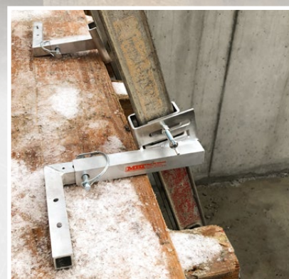
Clouage ou vissage du support d'échelle sur le coffrage de dalle ou la dalle bétonnée
