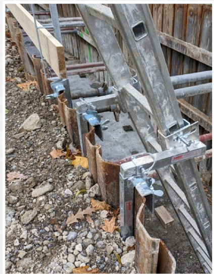
Compatible avec tous les adaptateurs de poteaux enfichables MBT, p. ex. l'adaptateur pour palplanches
