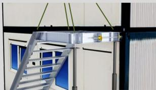
Ajuster les pieds d'appui au terrain et les serrer avec des vis. Il faut veiller à ce que le palier soit horizontal.
