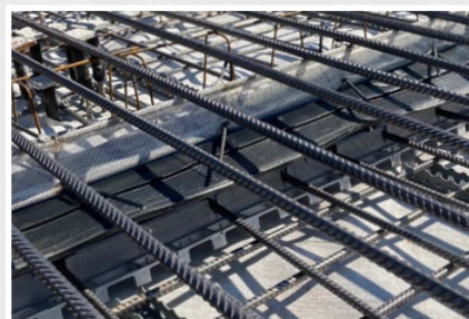
Ensuite, introduire simplement les bandes couvre-joint/tôles et poser l'armature supérieure
