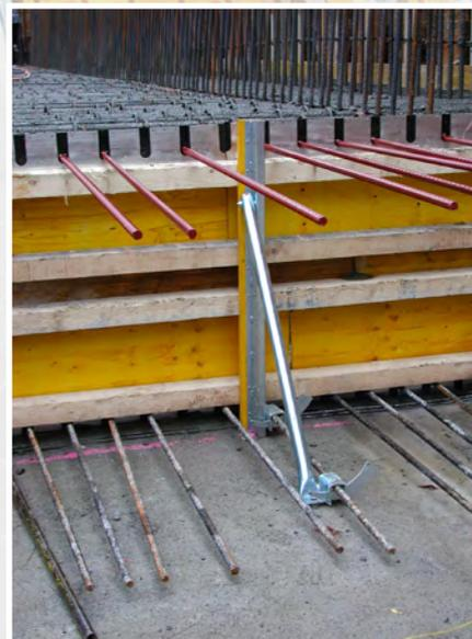
Support de coffrage AST SK fixé au fer d'armature inférieur...
