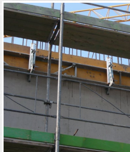
Utilisation de la console BKA Pro 30 cm avec échafaudages de façade
