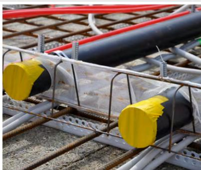
*Pour intégrer diverses installations (par ex. des tuyaux), incisez simplement une croix, faites passer l'installation, puis collez les languettes du treillis sur l'installation à l'aide d'un ruban adhésif pour béton.*
