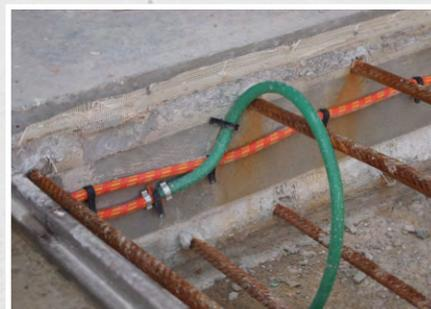
Roll-Net peut également être utilisé en combinaison avec des tuyaux à injection
