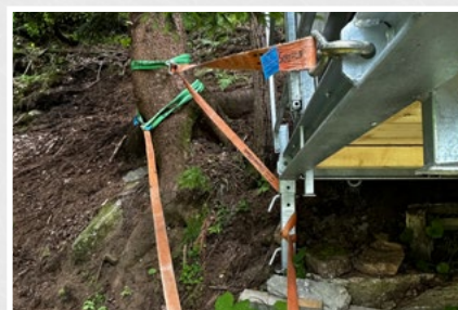
De nombreux points d'accrochage permettent un ancrage en toute sécurité
