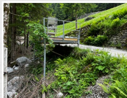
Plateforme pour pente montée avec rallonge d'étais
