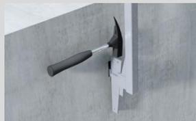
S'assurer que l'adaptateur BKA Pro est correctement placé dans la réservation BKA une fois monté et bloqué.
