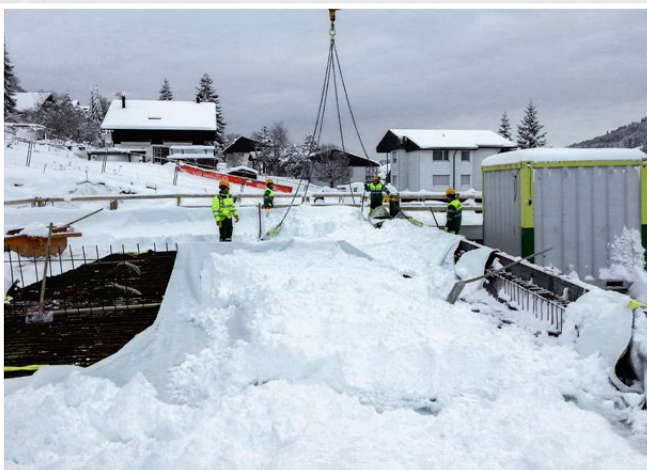
Déneigement simple et rapide sur le chantier
