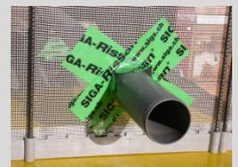
Pour des traversées plus importantes, les crochets doivent être en plus collés aux éléments intégrés.
