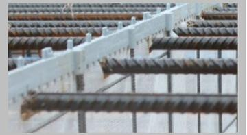
Selon la méthode de bétonnage nous recommandons d'utiliser notre BPA coffrage pour radier ou Équerre de coffrage à partir d'une épaisseur de dalle de 36 cm. Place le BPA ou l'équerre de coffrage à une distance de 2 mètres pour stabiliser la Net-Form.
