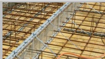
Enfoncer l'armature inférieure au-dessus de la baguette en plastique.
