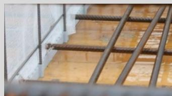
Enfoncer l'armature supérieure entre la baguette en plastique et la ferrure transversale.
