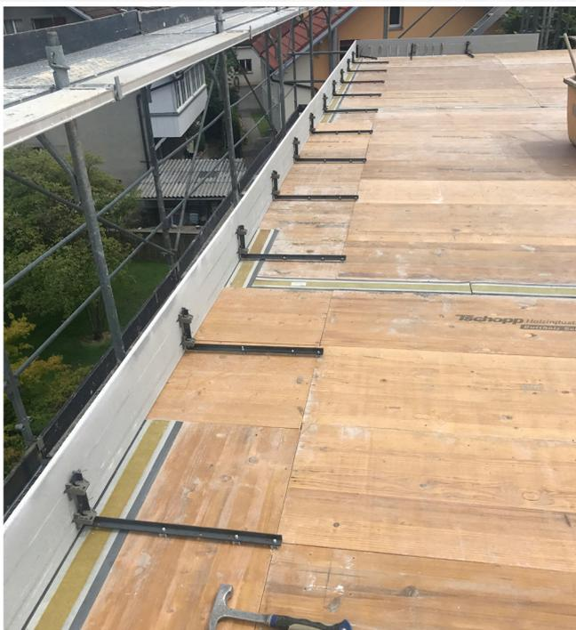
Pour le montage de l'élément Bordfix de 2,8 m de long, les équerres sont dépliées, l'élément est poussé contre la rive de dalle et fixé avec des clous en aluminium.
