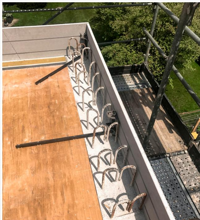
Les équerres peuvent être déplacées horizontalement et en continu, par exemple pour éviter des fers de raccord, des paliers lisses et des inserts.
