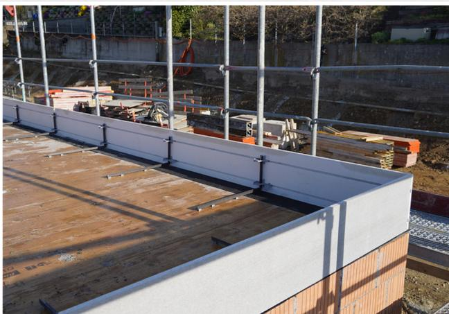
Dans les angles ou dans le sens longitudinal, les éléments Bordfix peuvent être assemblés solidement à l'aide des coulisses.
