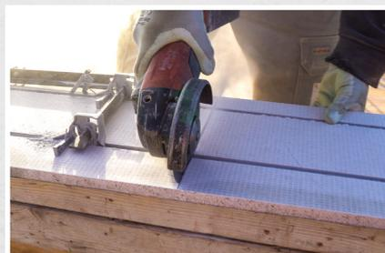
L'élément Bordfix peut être raccourci à la longueur désirée à la scie sauteuse ou à la meuleuse d'angle
