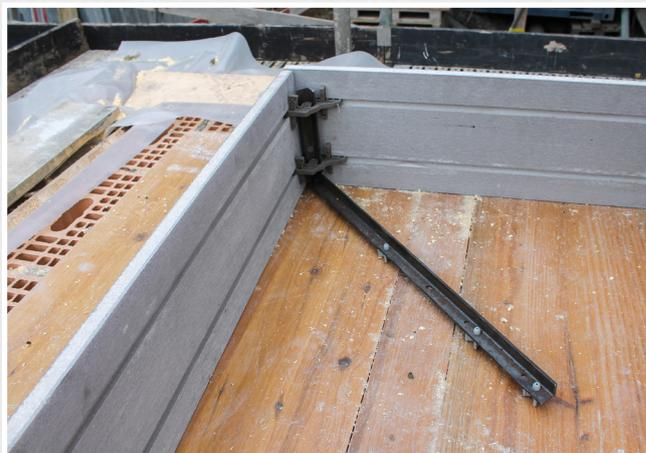
Les équerres de coffrage Bordfix peuvent être dépliées et orientées en continu jusqu'à 90°.
