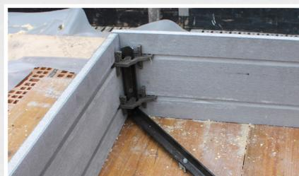
Dans les angles aussi, les éléments peuvent être assemblés solidement et les équerres peuvent être inclinées
