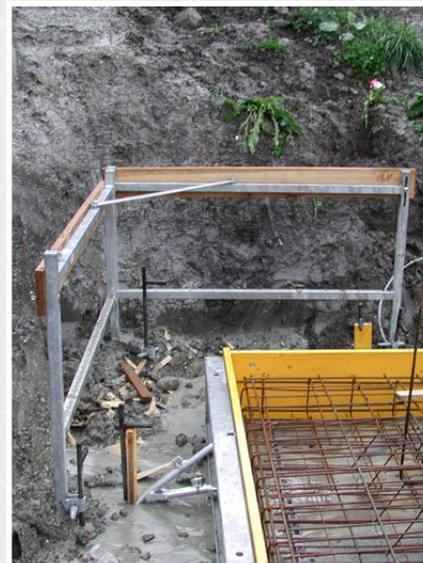
Charpente de support Speedy utilisé
