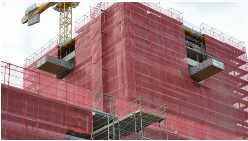
Plateforme MS extrême utilisée
