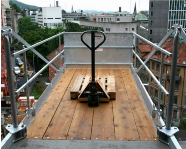
Le montage à ras de dalle garantit un transbordement de marchandises plus simple
