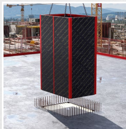
Elle sert en plus d'échafaudage de travail lourd ou pour la pose de coffrages de cage
