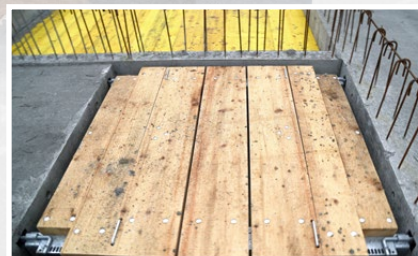
La plateforme Lift empilable permet la sécurisation rationnelle d'ouvertures de cage d'ascenseur
