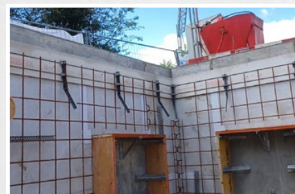
Dans le sens longitudinal et dans les angles, les éléments peuvent être reliés par jonction de force
