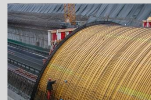
Top-Form dans la construction de tunnels
