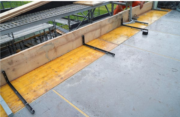
Mit dem Randfix System schalen Sie Deckenränder sehr rationell ab
