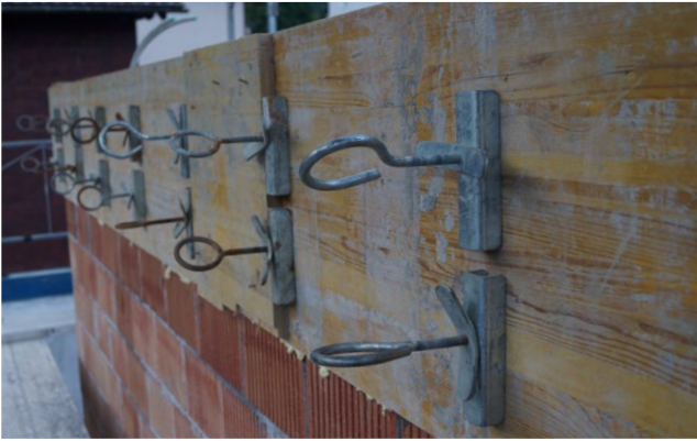
Beim Randfix-Winkel Art. 1105 werden zwei Spanneisen verwendet
