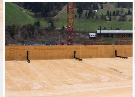
Randfix bei der Abschalung von Deckenrändern
